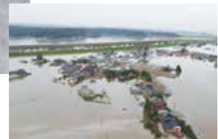
2019年台風15号による被害の様子
